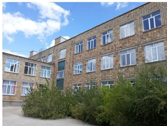
Текущий ремонт оконных проемов
